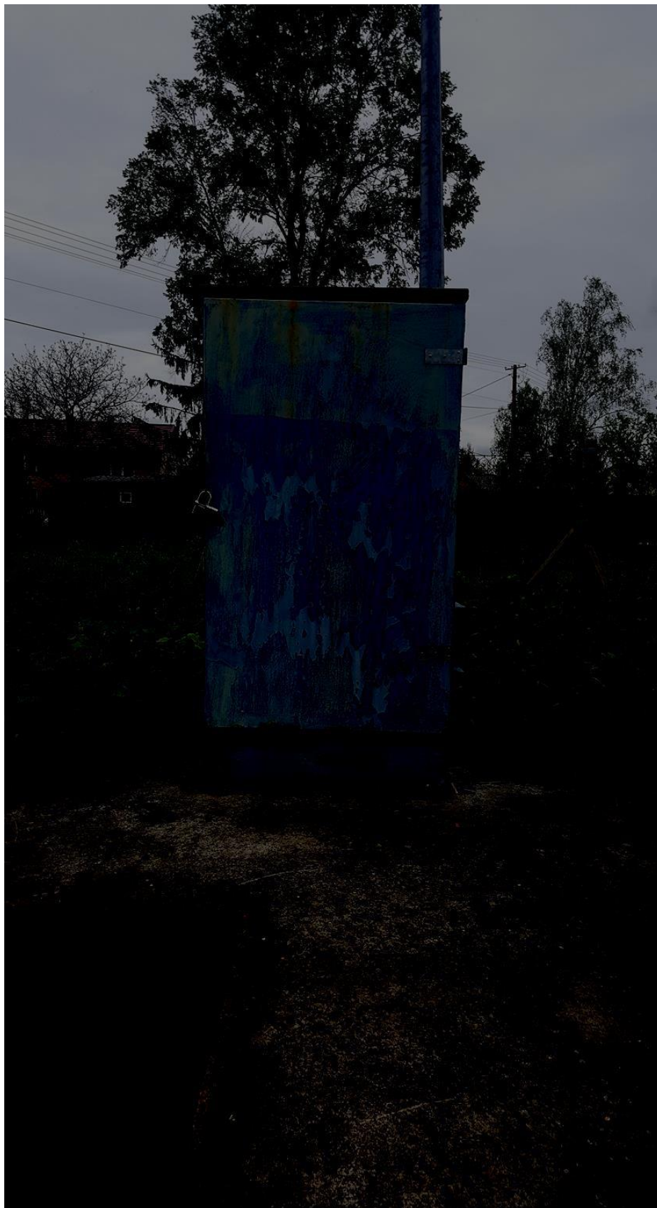
Rysunek nr 3. Szafa zasilająco sterownicza – widok zewnętrzny
