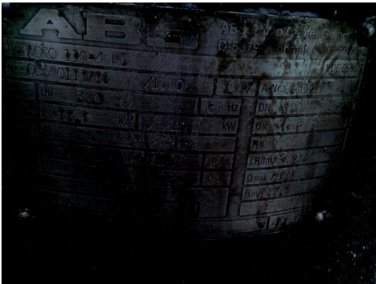
Rysunek nr 5. Tabliczka znamionowa istniejącej pompy ABS ARGO 110-4HD, P 2 =11kW.
