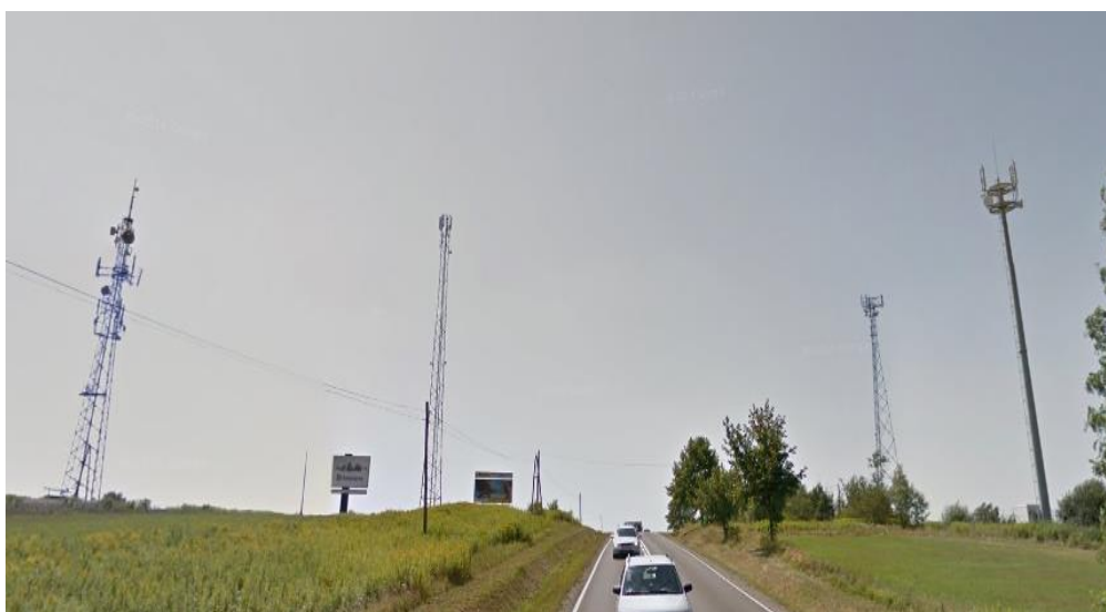
Fot. 1. Stacje telefonii komórkowej w miejscowości Jeżowe
