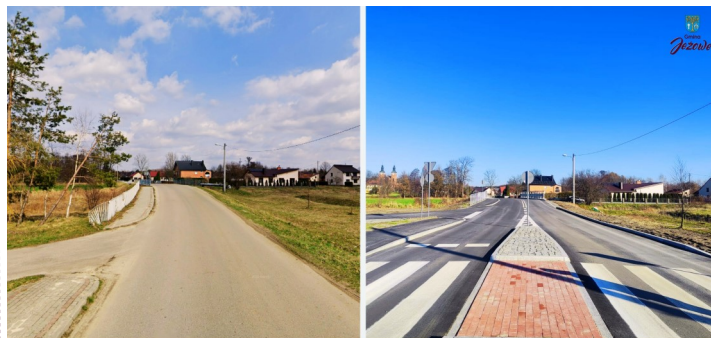
Przebudowa drogi gminnej nr 102312R w miejscowości Jeżowe od km 0+000 do km 0+308
