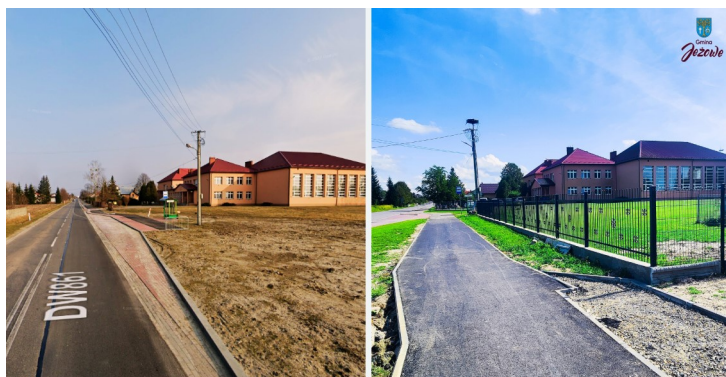
Rozbudowa drogi wojewódzkiej nr 861 polegająca na budowie ścieżki rowerowej z dopuszczeniem ruchu pieszych w msc. Jeżowe Kameralne, Jata i Sójkowa
