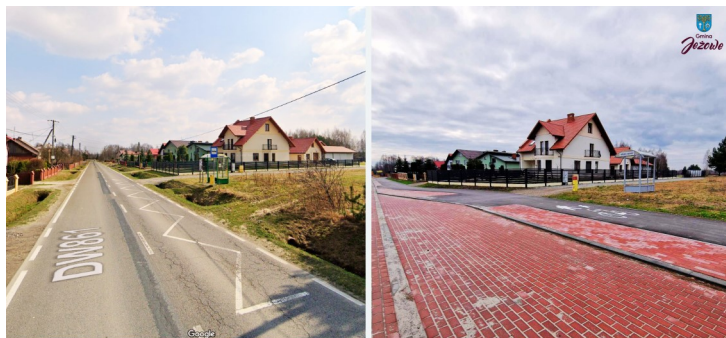
Rozbudowa drogi wojewódzkiej nr 861 polegająca na budowie ścieżki rowerowej z dopuszczeniem ruchu pieszych w msc. Jeżowe Kameralne, Jata i Sójkowa
