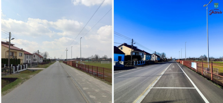
Poprawa infrastruktury drogowej na terenie gminy Jeżowe poprzez przebudowę i rozbudowę dróg gminnych nr 102312R, 102315R, 102317R w miejscowości Jeżowe
